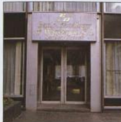
Bank Handlowy w Warszawie
